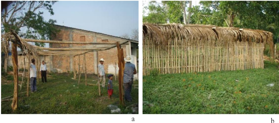
Figura 5. Construcción del vivero comunitario, con materiales adquiridos en la comunidad. a) inicio de la estructura del vivero, utilizando como postes troncos de Spondias sp., con vigas de bambú Guadua sp., y b) parte de la estructura del vivero finalizada, con la cerca de bambú y techo de palma.
